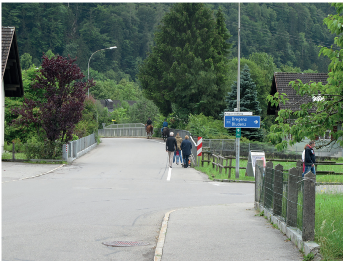
Abb. 20: Die Brücke als Verbindung zwischen Stallehr und Bings ist eine Gefahrenstelle für Fußgänger*innen
